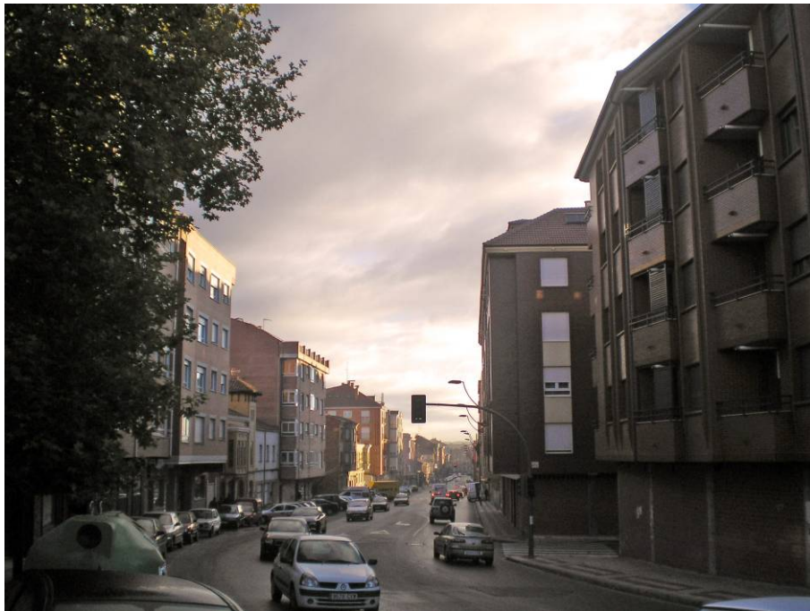
Avda. Párroco Pablo Díez en el Tramo 3
