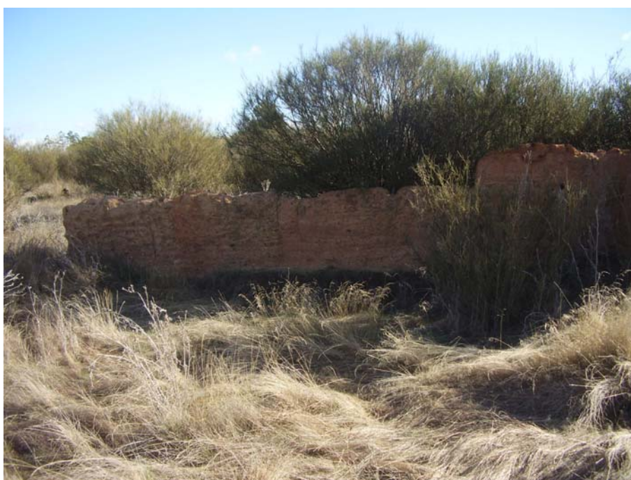
Vista detallada de algunas de las estructuras conservadas en pie, parcialmente semiocultas entre la espesa vegetación.
